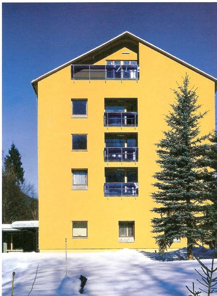
Původní zděná fasáda zámečku má po rekonstrukci nahodile vylícované a zapuštěné okenní otvory. Modré balkóny v jižním průčelí zakončují a prosvětlují střední chodbu.
