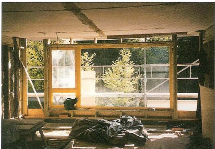
Původní panelový plášť byl rozebrán a nahrazen novým tepelně izolačním. (archiv autorů)
