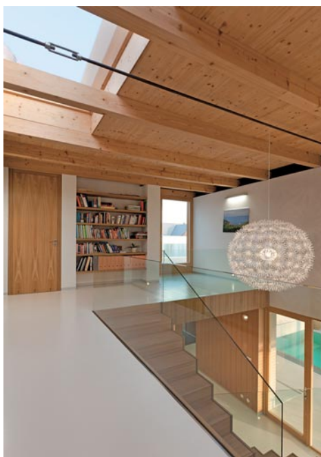
POHLEDOVÉ TRÁMOVÉ KONSTRUKCE V INTERIÉRU TVOŘÍ PLOCHOU STŘECHU, SCHODIŠTĚ JE PROSVĚTLENO STŘEŠNÍM SVĚTLÍKEM
